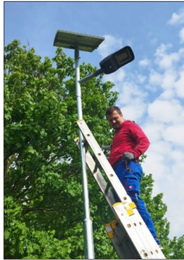
Ilustrační fotografie stejného typu úsporného osvětlení s pohybovým senzorem v Loučce, foto: Štěpán Olša
